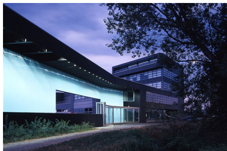
8. Milano, depuratore San Rocco
