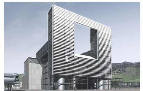
9. Catanzaro, centrale termoelettrica
