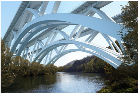
1. Fiume Adda, autostrada Pedemontana
