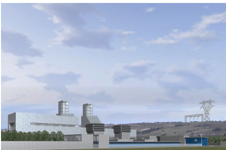
7. Termoli, centrale termoelettrica
